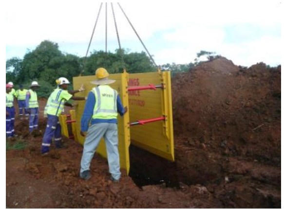
Reprise du terrassement Descente des caissons suivants. Blindage en A.
