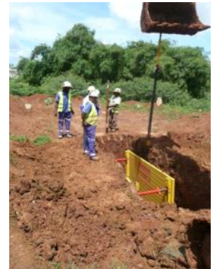
Pose du caisson en fond de fouille.
