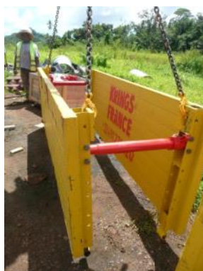
1 vérin à chacune des extrémités du caisson de rehausse
