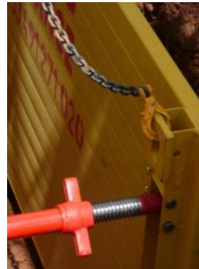
Pose du caisson en fond de fouille.
