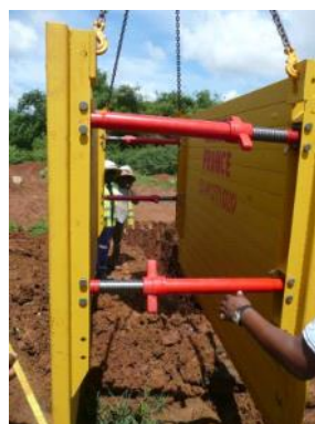
Montage des vérins en quinconce
