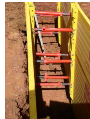
Veiller à préserver le contact entre les parois de blindage et le terrain
