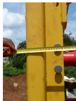
Ouvrir les vérins de la base du caisson un peu plus que ceux du haut
