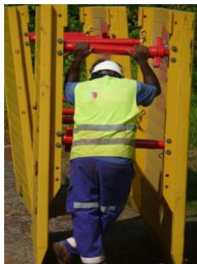
Ne pas tirer les caissons par les vérins
