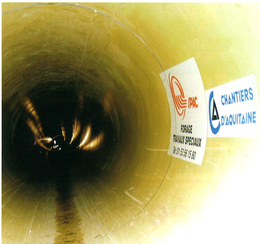
Le PRV, un matériau offrant une très faible rugosité adaptée aux pentes du projet (3 %) et des débits à évacuer
