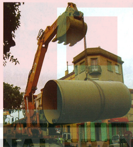
Le tuyau PRV présente un faible poids (515 kg/m) permettant une manutention plus facile et en toute sécurité
