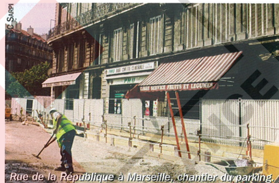
Rue de la République à Marseille, chantier du parking.
